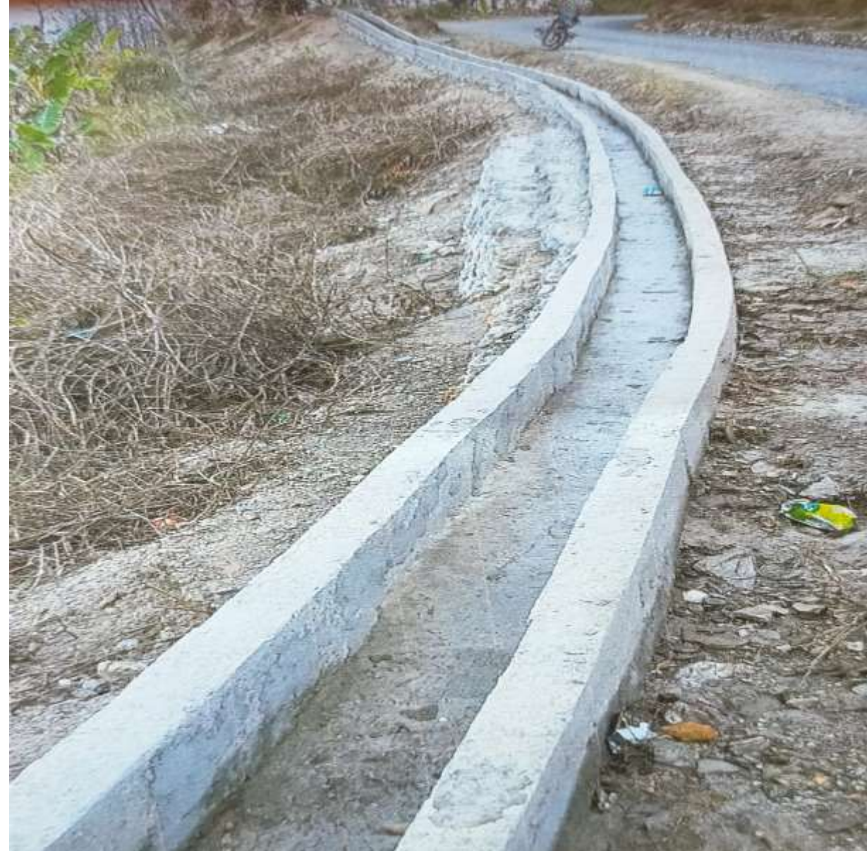
बोहोरा सिचाइ कुलो निर्माण, भेरी नगरपालिका-४
